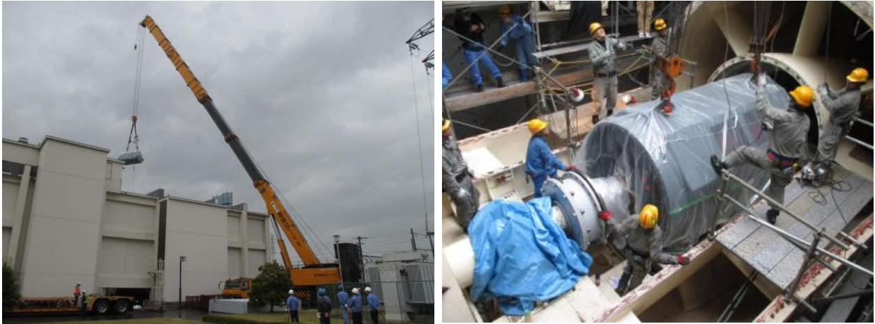
写真 モーター搬入時の様子
