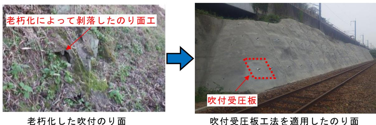
図2 開発した吹付受圧板工法の適用状況
