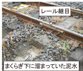
図2 施工前の現場
