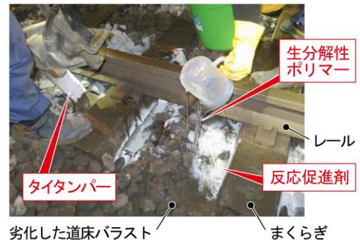
図1 生分解性ポリマーを用いたバラスト安定処理工法の施工状況
