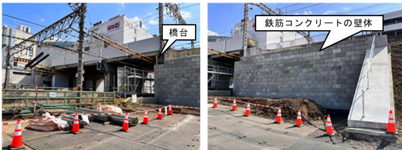
(a) 現場の施工状況
