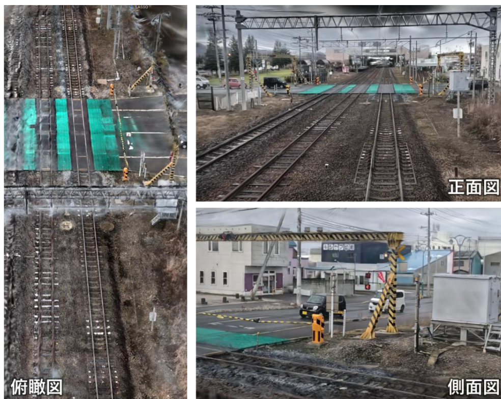
図 3 上下線の映像を統合して構築した3次元線路空間例
