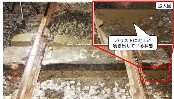
参考図 バラストの劣化の例
