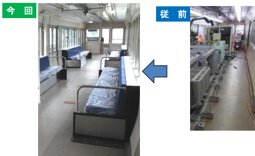
図3 機器が撤去された室内
