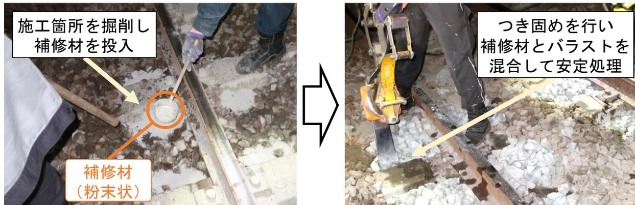
図3 低強度安定処理工法の施工（ハンドタイタンパーを用いた施工方法）
