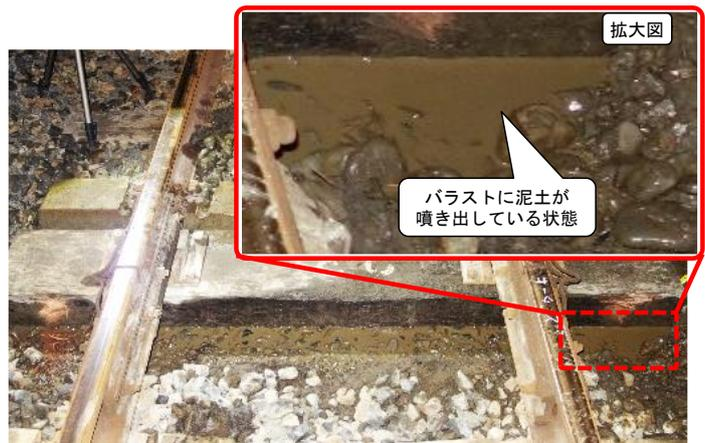
図1 劣化したバラストの例
