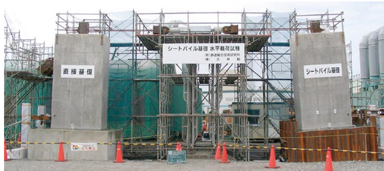
図 実大規模の水平載荷実験状況
