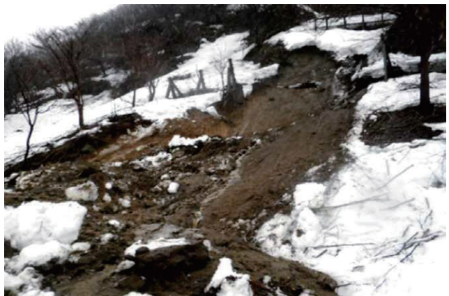
図 融雪期の斜面崩壊(融雪災害)の例
