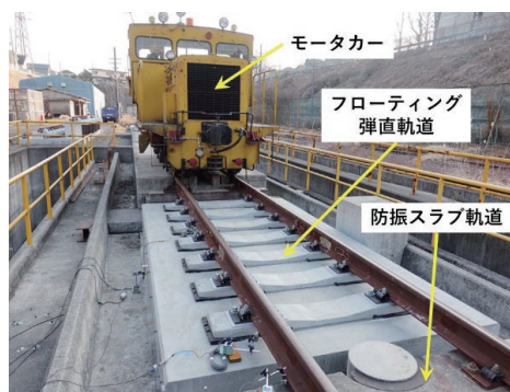
図12 施工後の状況
