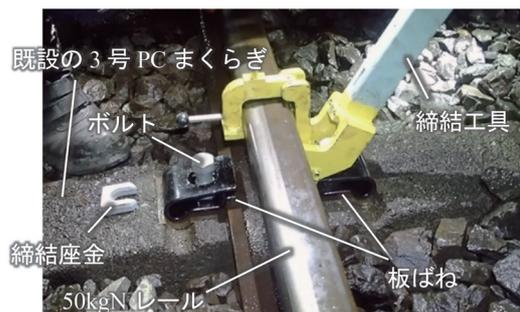
図 16 締結工具を用いた施工の状況
