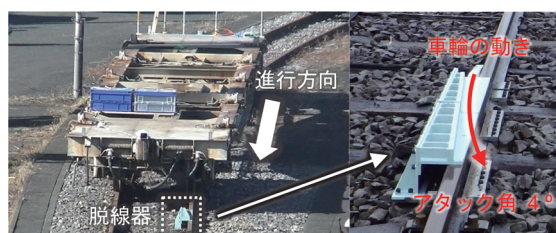
図12 脱線器の設置状況
