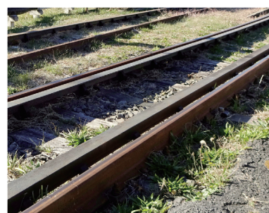
図8 在来線用脱線防止ガード 8)
