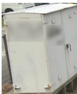
図 14 劣化度が最小の踏切器具箱
