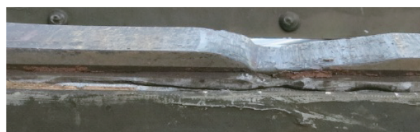
図2 すり板局部摩耗の例
