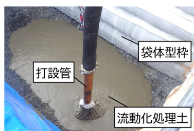
図 8 施工試験における処理土の打設状況
