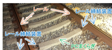
(a) 軌道の構成の例（バラスト軌道）
