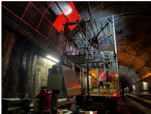
図 11 高所作業車台上での打音調査の試行
