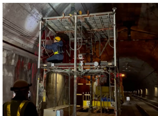
図2 鉄道トンネルの打音調査の例
