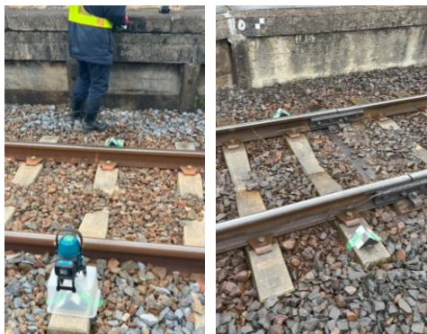
図 8 地上マーカ施工の様子
