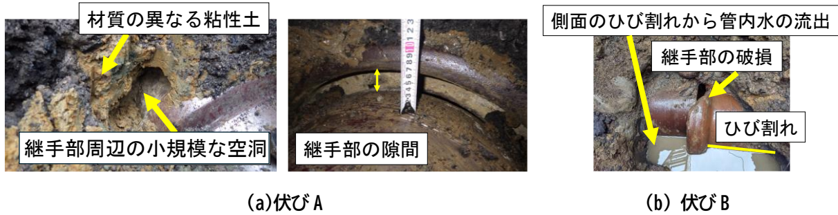
図4 伏びの掘削状況
