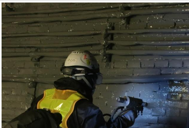
吹付けの状況
