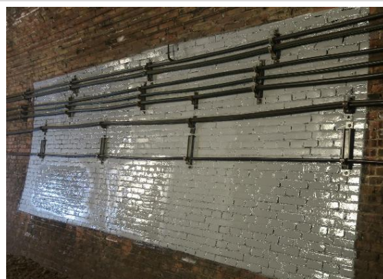
吹付けの仕上がり
