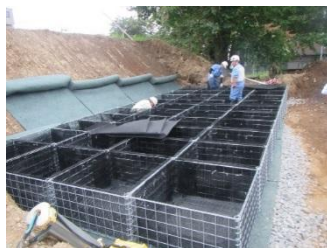
②かご枠組立て
