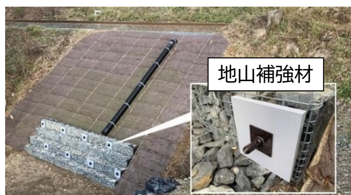
台風により被災した集水地形の盛土
