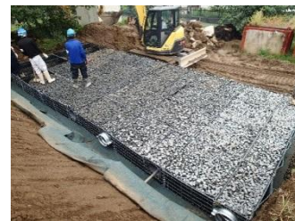
③中詰め・転圧
