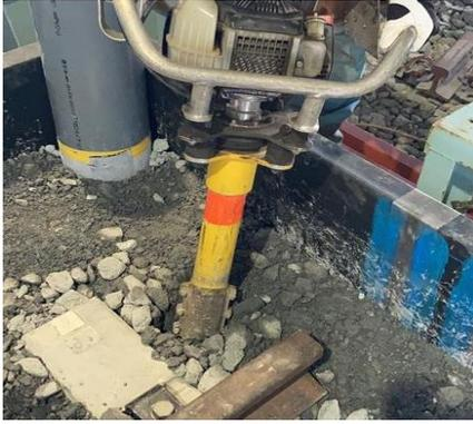
①つき固め補修箇所を掘削
