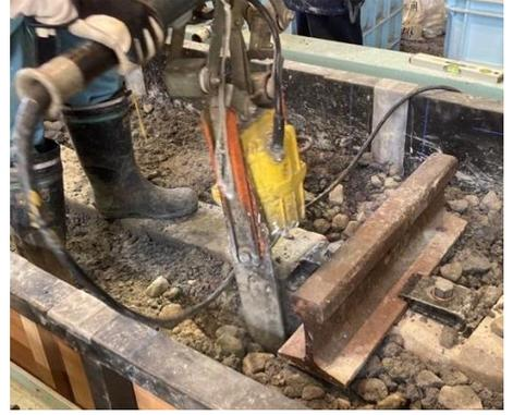
③通常と同様のつき固め補修で、バラストと補修材を混合
