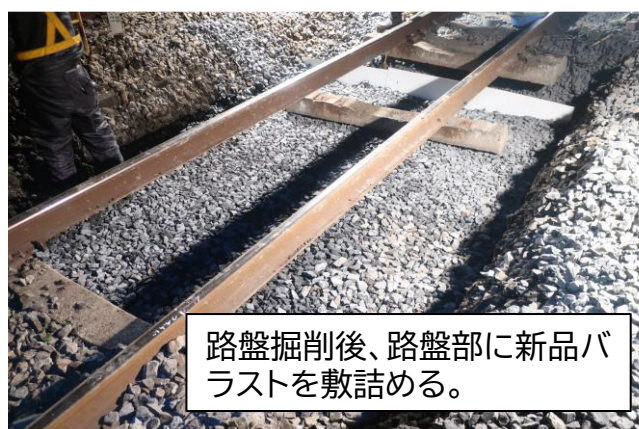
路盤部に新品バラストを敷詰めた状況
