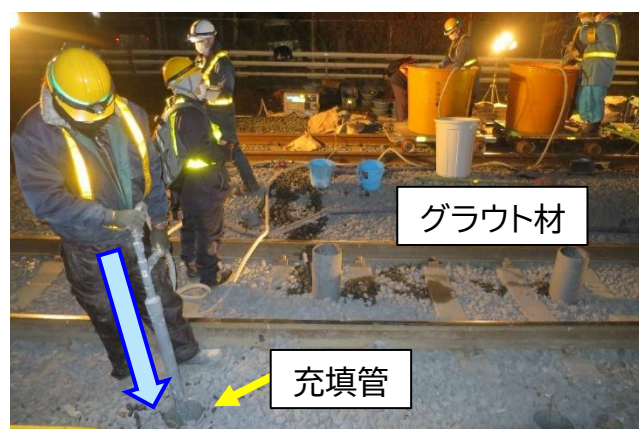
グラウト充填作業の状況
