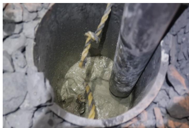
グラウト充填時の充填管内の状況
