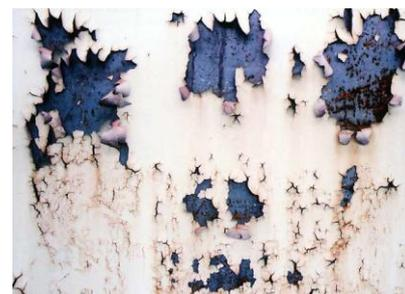
旧塗膜の劣化に起因する変状例 (剥がれ、割れ)
