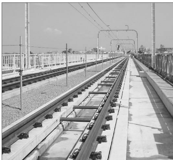
図2 L形台座防振材式フローティング・ラダー軌道の敷設事例
