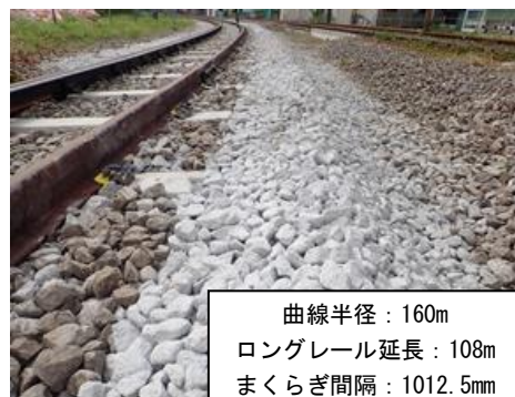
図5 構内試験線への試験敷設状況
