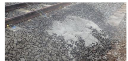
(a) 細粒土混入バラストに セメント・水を添加
