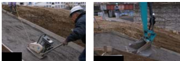
(b) プレート転圧 (c) バケツ転圧
