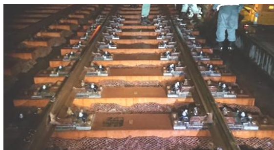
図7 試験敷設の状況
