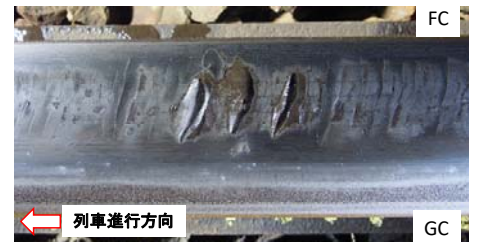
図1 中きしみ割れの外観
