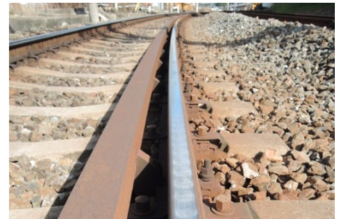
図1 レール波状摩耗の例
