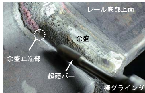
図5 余盛止端部の研磨処理状況
