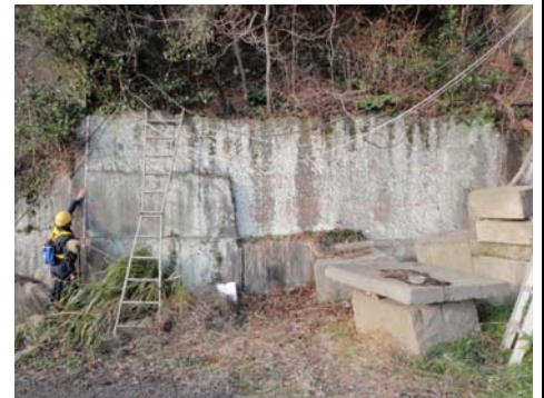
図1 のり面の状況
