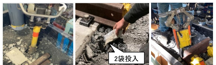
(a) 穴あけ (b) 補修材投入 (c) つき固め補修 図4 低強度安定処理工法の施工方法
