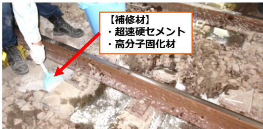
(a) 補修材投入
