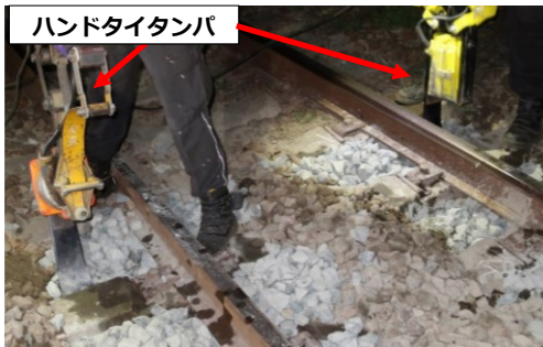
(b) つき固め補修
