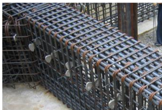
図 1 RC ラーメン高架橋梁の配筋例（地中梁）
