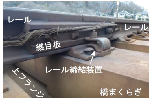
図 1 レール継目（支え継ぎ）
