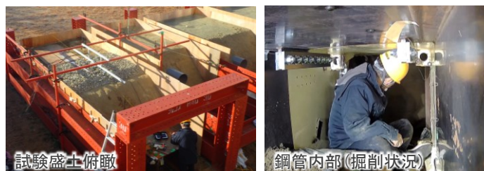
図5 実物大掘削実験
