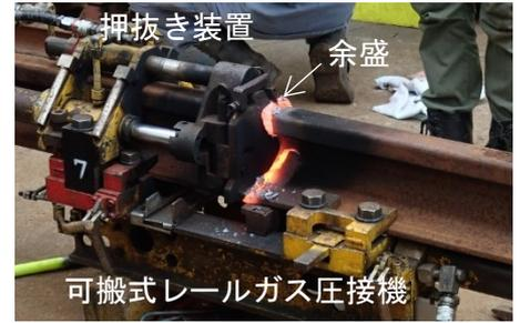
図 1 余盛押抜き時の様子
