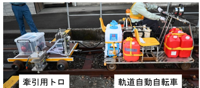
図2 黒色皮膜除去装置の施工時の外観（2台目）
