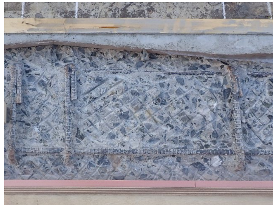
図 4 はつり面におけるクロス状の溝 （深さ：約 2mm，間隔：約 25mm）
