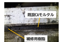
(b) 補修箇所
