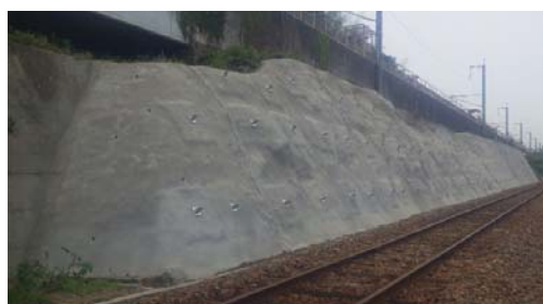
図 7 吹付受圧板（FSC パネル）工法の施工例
