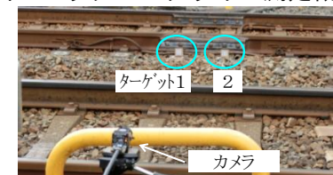
図3 PCまくらぎの測定状況
