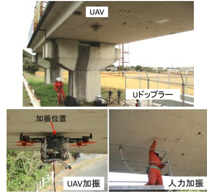
図7 測定・加振状況
