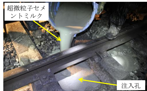
図 6 超微粒子セメントミルクの注入状況
