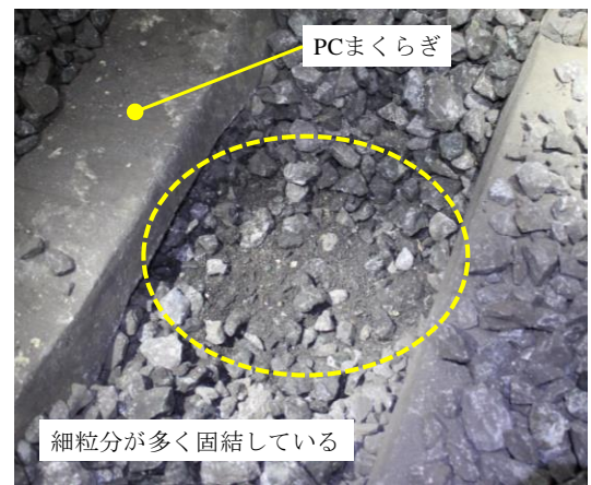
図1 営業線のバラスト道床の状況
