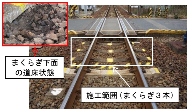
図6 試験施工箇所の状況
