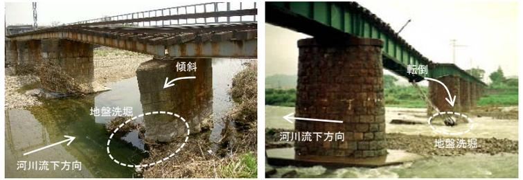
図1 橋脚の傾斜・転倒事例
