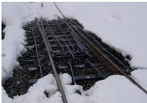
図1 分岐器への散水(チョロ散水とも呼ばれます)
