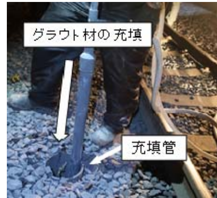
図5 グラウト充填状況
