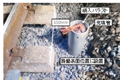
図4 充填管の設置
