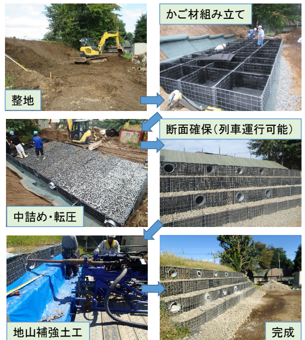
図3 提案構造の施工手順
