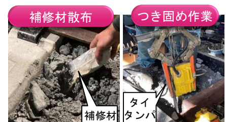
図1 低強度安定処理工法の施工方法
