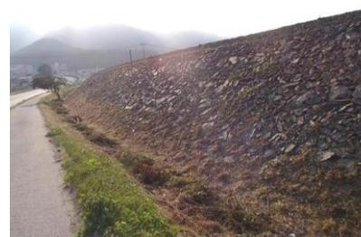
図5 三陸鉄道南リアス線の盛土被害 (岩座空張のずれ)
