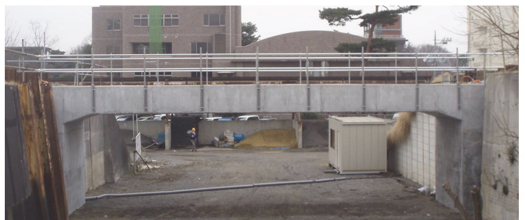
図2 GRS 一体橋梁の実物大試験橋梁
