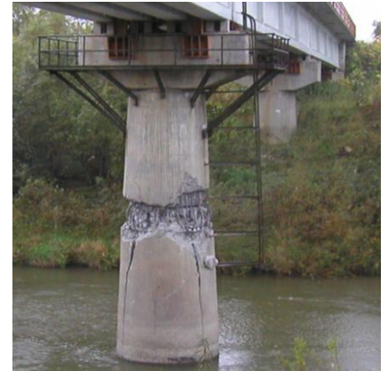
図 1 地震による段落し部の被害状況 1)
